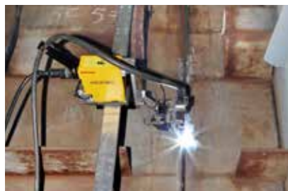
爬坡焊（钢箱梁桥）
