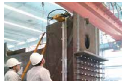
立焊（桥梁钢锚箱）
