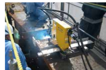
平焊（桥梁现场）
