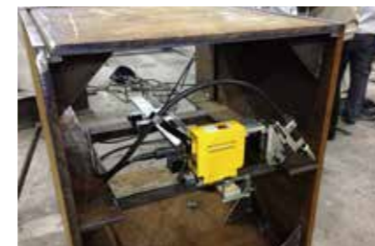
水平角焊（钢桁梁桥）
