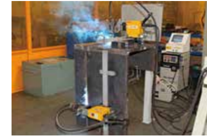
平焊、立焊（舱口围板）
